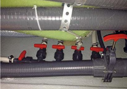
**Die Entleerungshähne zur Entleerung des Whirlpools sind werkseitig geschlossen.** Vor Befüllung des Whirlpools ist dies nochmals zu überprüfen. Die Ventile sind geschlossen, wenn sich der Drehgriff quer zur Leitung befindet. Die Ventile sind geöffnet, wenn sich die Griffe in Richtung der Leitung befinden.
